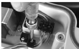
10. Bloquer le câble dans le serre-câble et enfiler le passe-câble dans le couvercle du boîtier.
